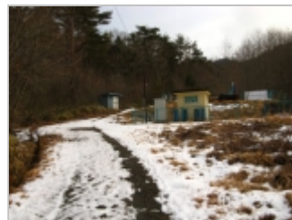
林道終点の水道施設
